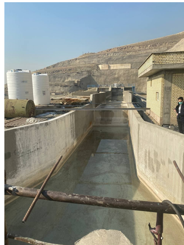
سازه پارشال فلوم مجهز به تراز یاب Ultrasonic
