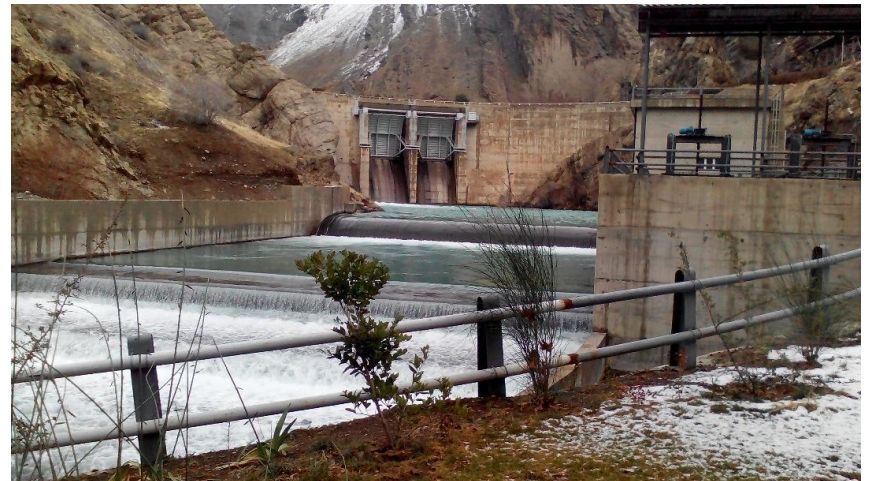
سد تنظیمی - سد انحرافی دهانه آبگیر به تونل انتقال آب شرب تهران
