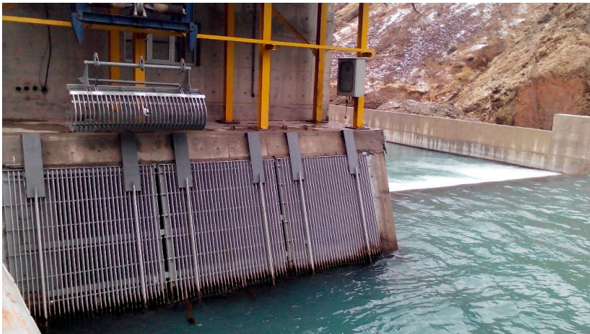
دهانه آبگیر و سازه آشغال گیر
