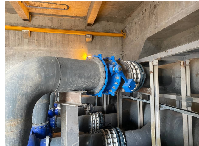
شیر یک طرفه به منظور جلوگیری از آسیب ضربه قوچ
